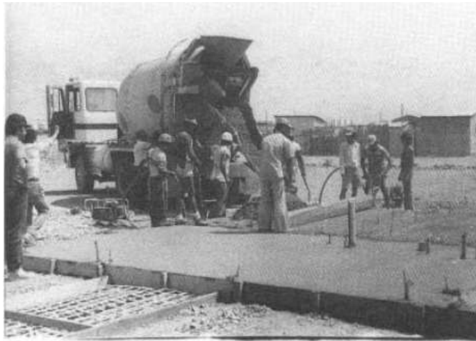
Gambar 5. Bambu sebagai tulangan pondasi plat. (Hidalgo, 1995)
